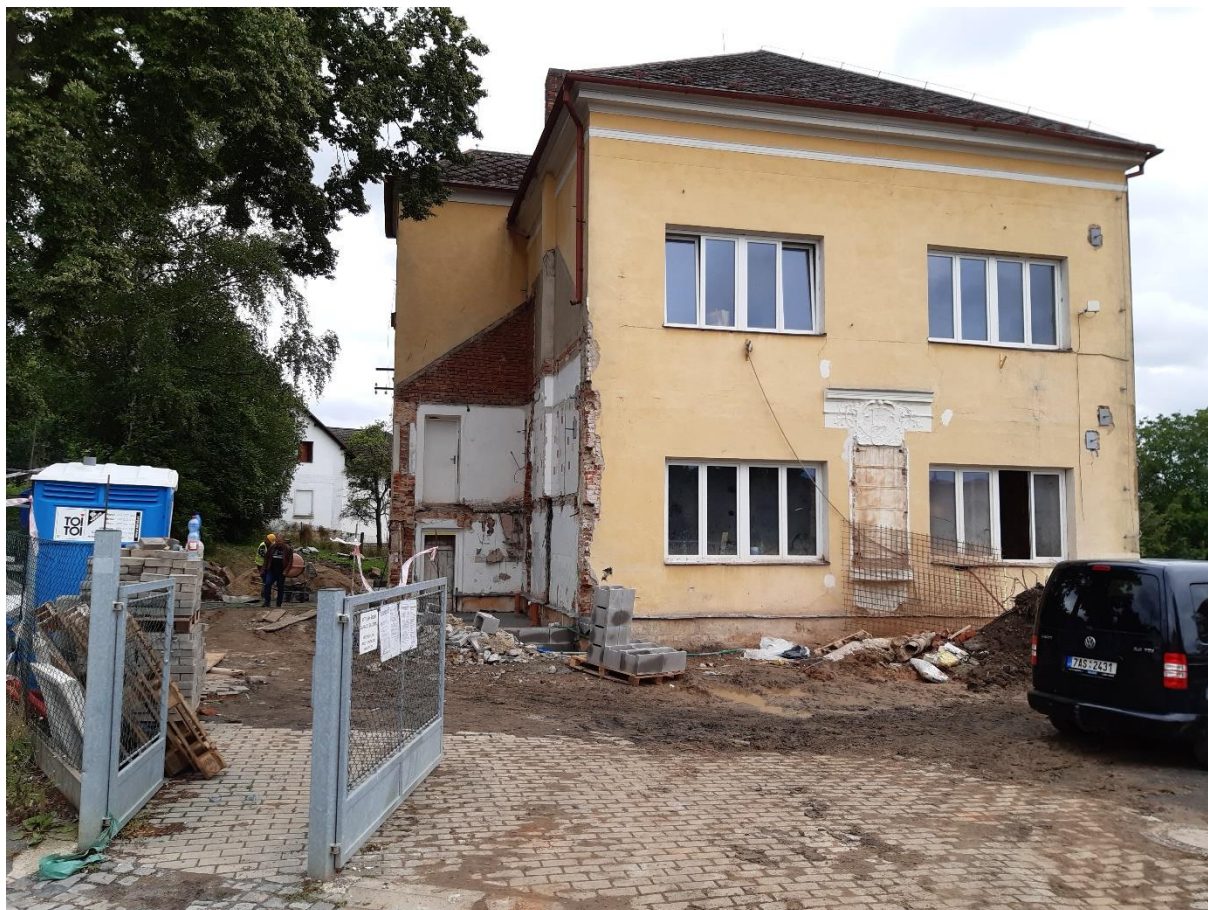
Škola na začátku rekonstrukce, srpen 2020
